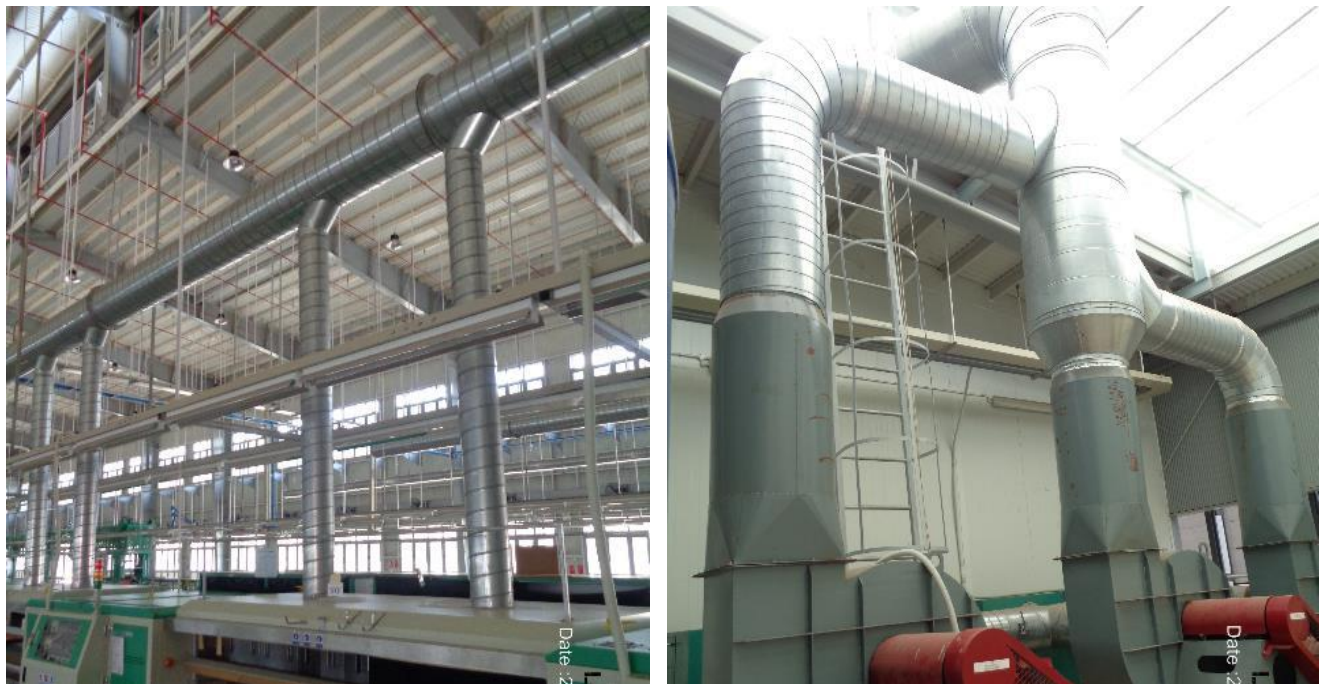
Hình 3.10. Hình ảnh hệ thống xử lý hơi keo nhà xưởng F25
