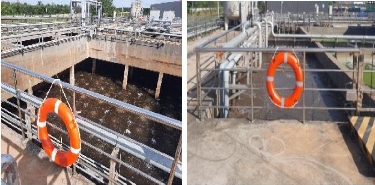
Hình 3.3. Hình ảnh hệ thống XLNT sinh hoạt công suất 2.400 m 3 /ngày.đêm
