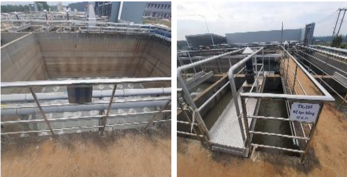
Hình 3.4. Hình ảnh hệ thống XLNT sản xuất công suất 1.200 m 3 /ngày.đêm
