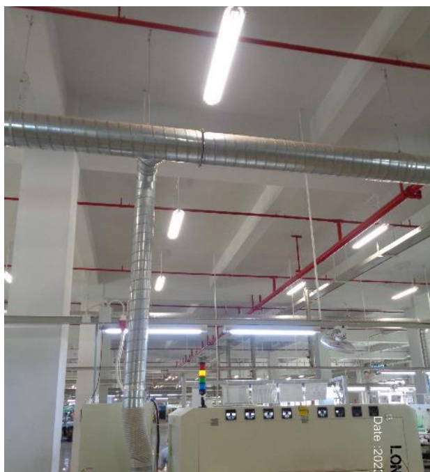
Hình 3.8. Hình ảnh hệ thống xử lý hơi keo nhà xưởng F20
