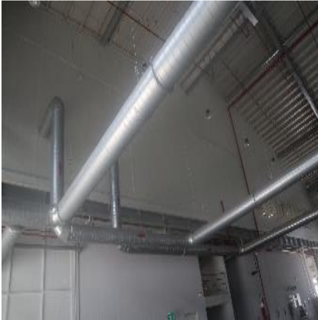
Hình 3.5. Hình ảnh hệ thống xử lý hơi keo nhà xưởng F24
