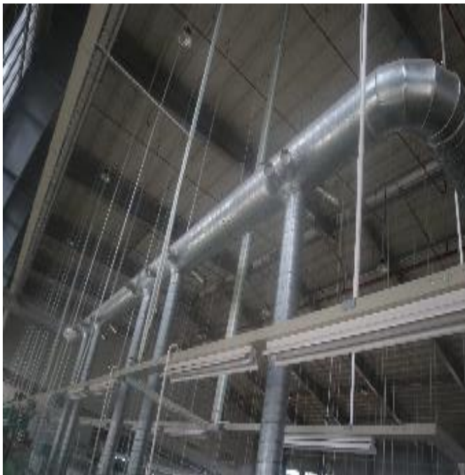
Hình 3.6. Hình ảnh hệ thống xử lý hơi keo nhà xưởng F26
