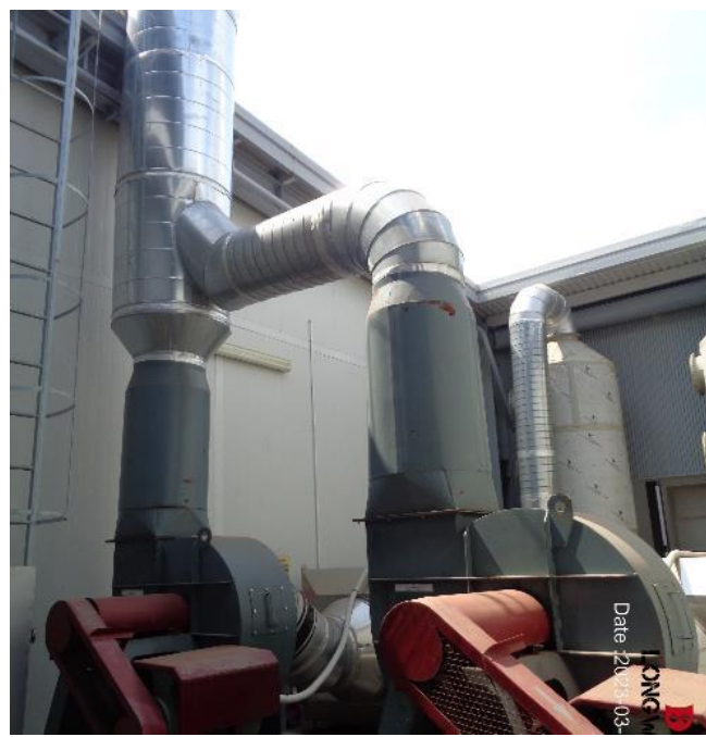
Hình 3.8. Hình ảnh hệ thống xử lý hơi keo nhà xưởng F20
