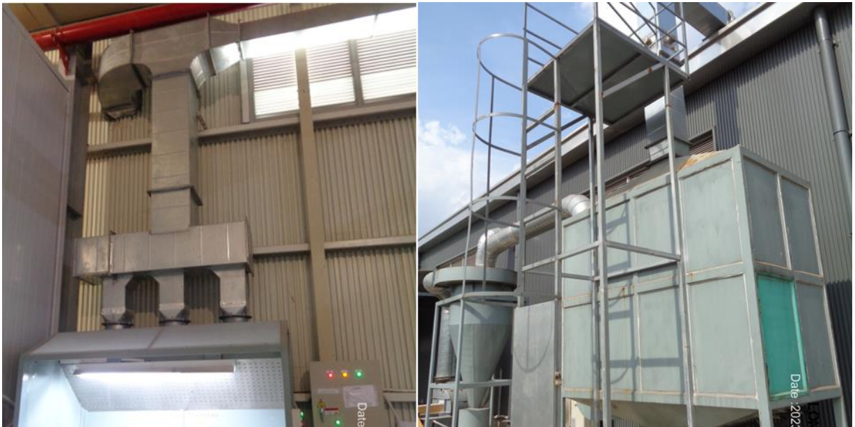
Hình 3.17 .Hình ảnh hệ thống xử lý bụi nhà xưởng M6
