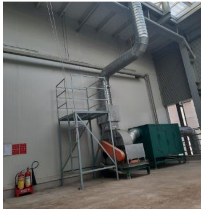
Hình 3.6. Hình ảnh hệ thống xử lý hơi keo nhà xưởng F26
