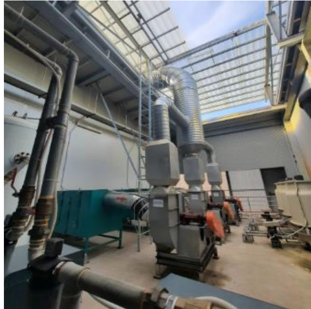
Hình 3.5. Hình ảnh hệ thống xử lý hơi keo nhà xưởng F24
